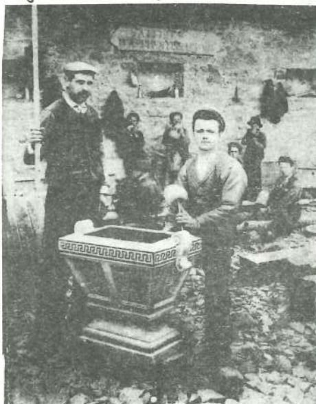
Atelier d'apprentissage n° 6. Carrière J. Cornet, A. Jaumot et C°, Ecaussinnes. Pierre d'épreuve exécutée par l'apprenti L. Deschayteneer. Chef d'atelier : N. Peters.
